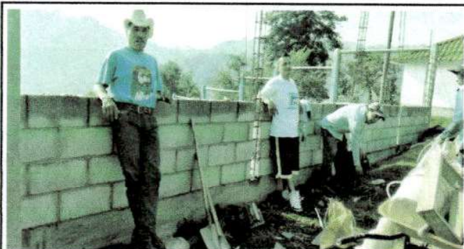
Foto 3: Vista muro perimetral de block y malla en proceso, ubicado en la derecha de los edificios escolares, pegado al graderío del campo de futbol.
