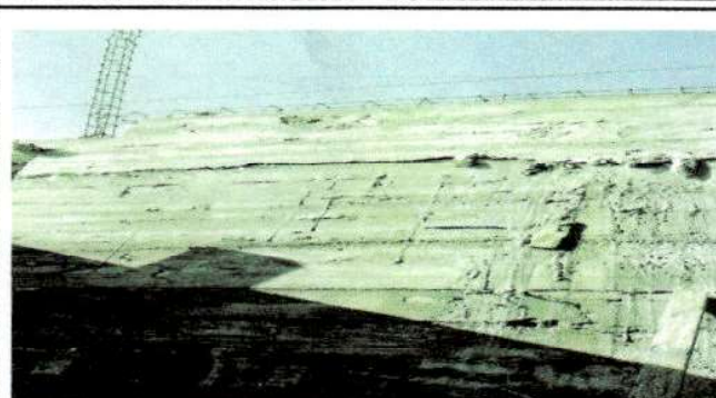
Foto 2: Vista del muro de contención en proceso, lado derecho de los edificios escolares, atrás de la cocina escolar.
