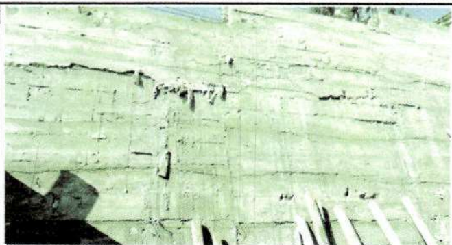
Foto 1: Vista del muro de contención en proceso, lado derecho de los edificios escolares, atrás de la cocina escolar, limite con terreno de vecino de la comunidad
