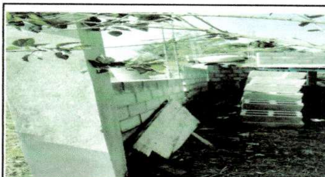
Foto 4: Vista del muro perimetral de block en proceso, atrás de los lavamanos de concreto.
